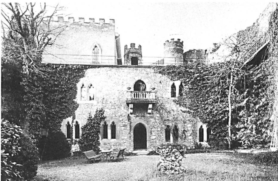
Abb. 14 La Neuveville, Schlossberg. Blick vom Innenhof auf den 1884/85 teilweise ausgebauten alten Palas. Die Öffnungen sind zum grösseren Teil noch mittelalterlich, die gezinneten Ausbauten dagegen Zutaten des späten 19. Jahrhunderts. Zustand vor den Veränderungen um 1930.
