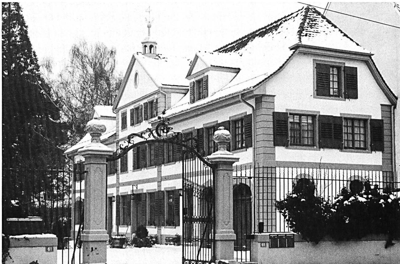
Iselin'sches Landgut in Riehen, Baselstr. 61 und 65. Die Aussenrenovation wurde 1986 abgeschlossen. Das abgebildete Ökonomiegebäude ist in vereinfachter Form ein Spiegelbild des Haupthauses, in dessen Innerem noch gearbeitet wird.
