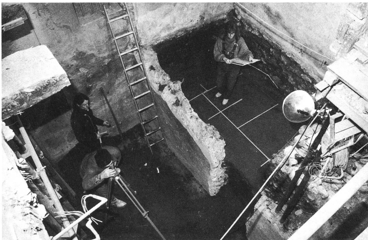
Die Ausgrabungen wurden während der Aushubarbeiten durchgeführt. Mehrere kleine Flächenuntersuchungen und Profilabschnitte ergeben zusammen ein Bild der römischen Bauabfolge. (Foto: Kantonsarchäologie).
