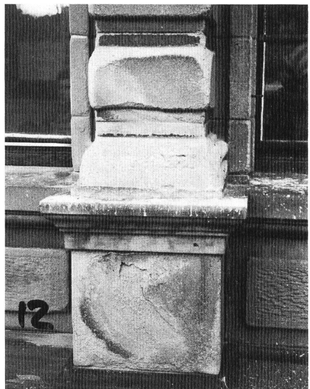
«Alte Töcherschule», Steinschäden an einem Fensterpfeiler des zweiten Obergeschosses.
