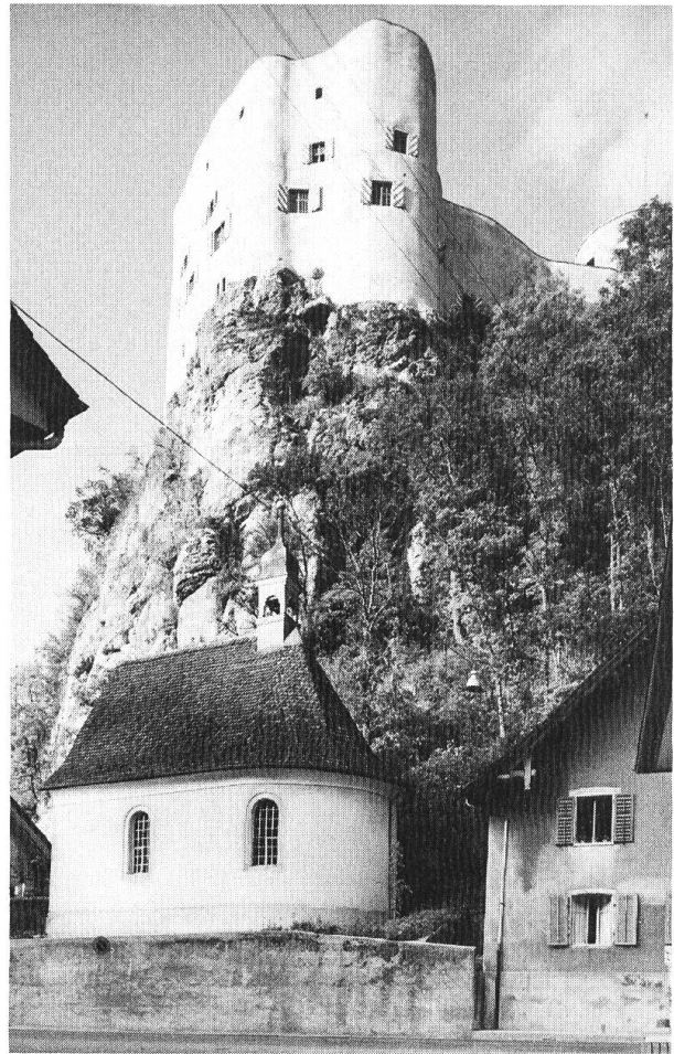
Burg Alt-Falkenstein nach der Restaurierung von 1955 und St. Josephskapelle.
