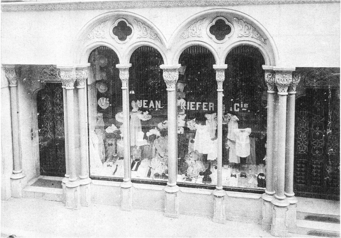
Schaufensteranlage Hauptgasse 12 (Foto Denkmalpflege).
