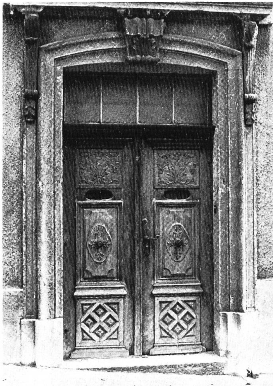
Die Haustüre, heute an der Rathausgasse.
