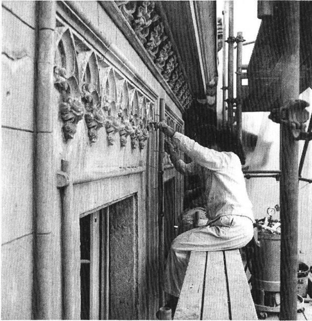
19 Fassade Gurzelngasse 7, während den Freilegungsarbeiten.
