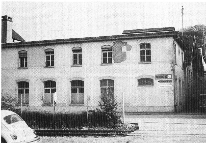
Heutiger Zustand des ehemaligen Betriebsgebäudes an der Industriestrasse 88/90.
