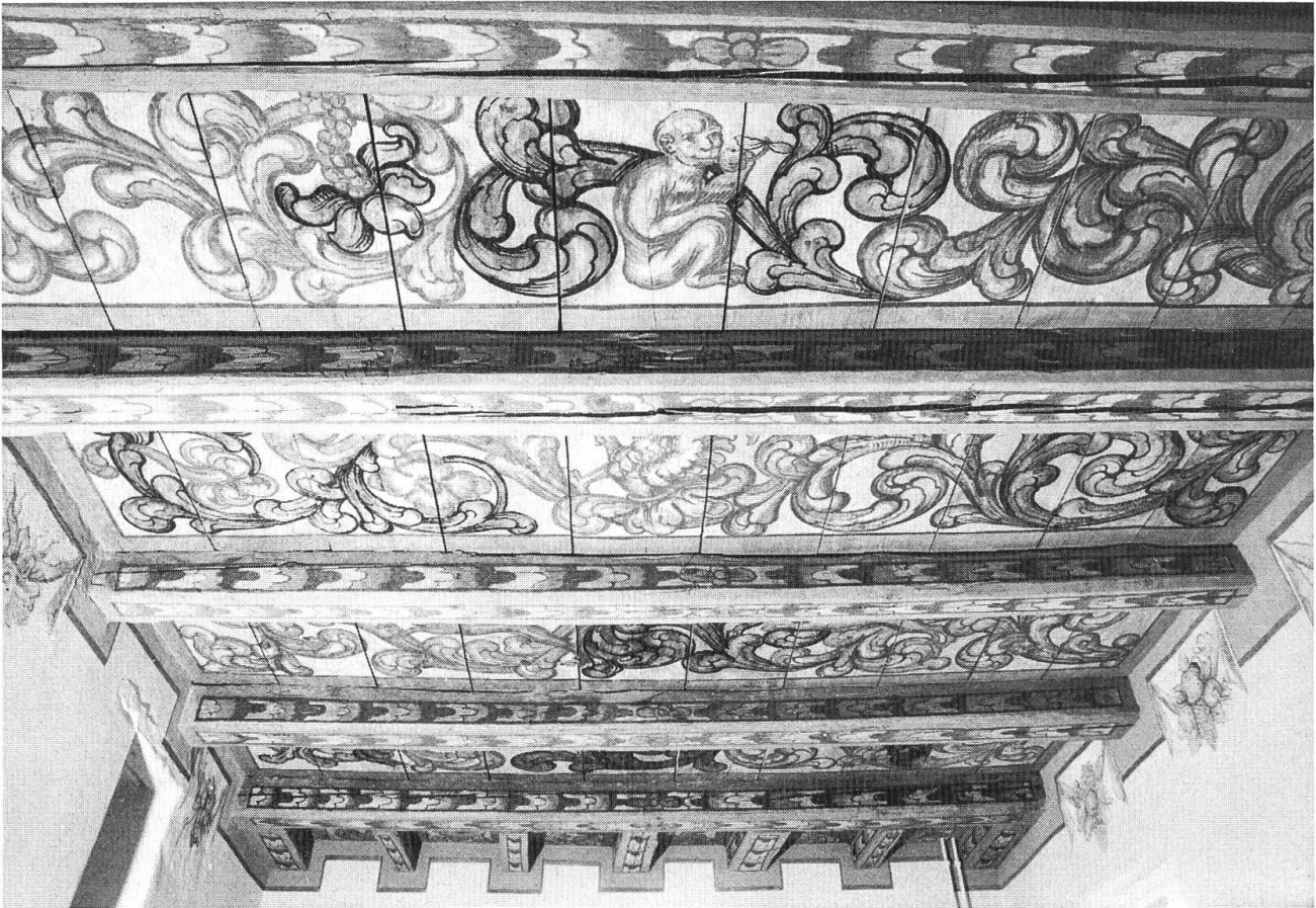
Schneidergasse 8. Bemalte Balkendecke im 3. Stockwerk.
