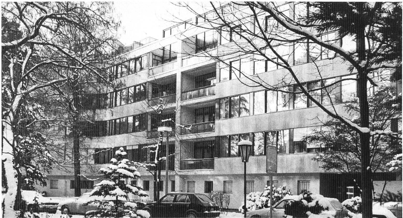
St. Alban-Anlage 37/39. Wohnhäuser von Otto Senn 1936. Sorgfältiger Ersatz der Fenster.
