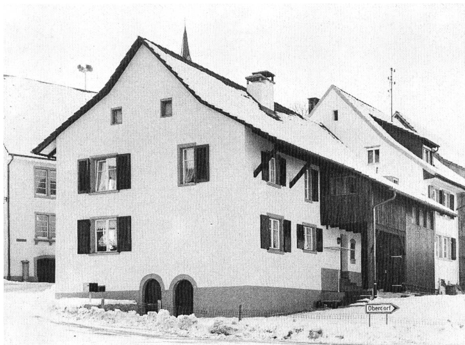
Bennwil, Haus Dorfstrasse 2.
