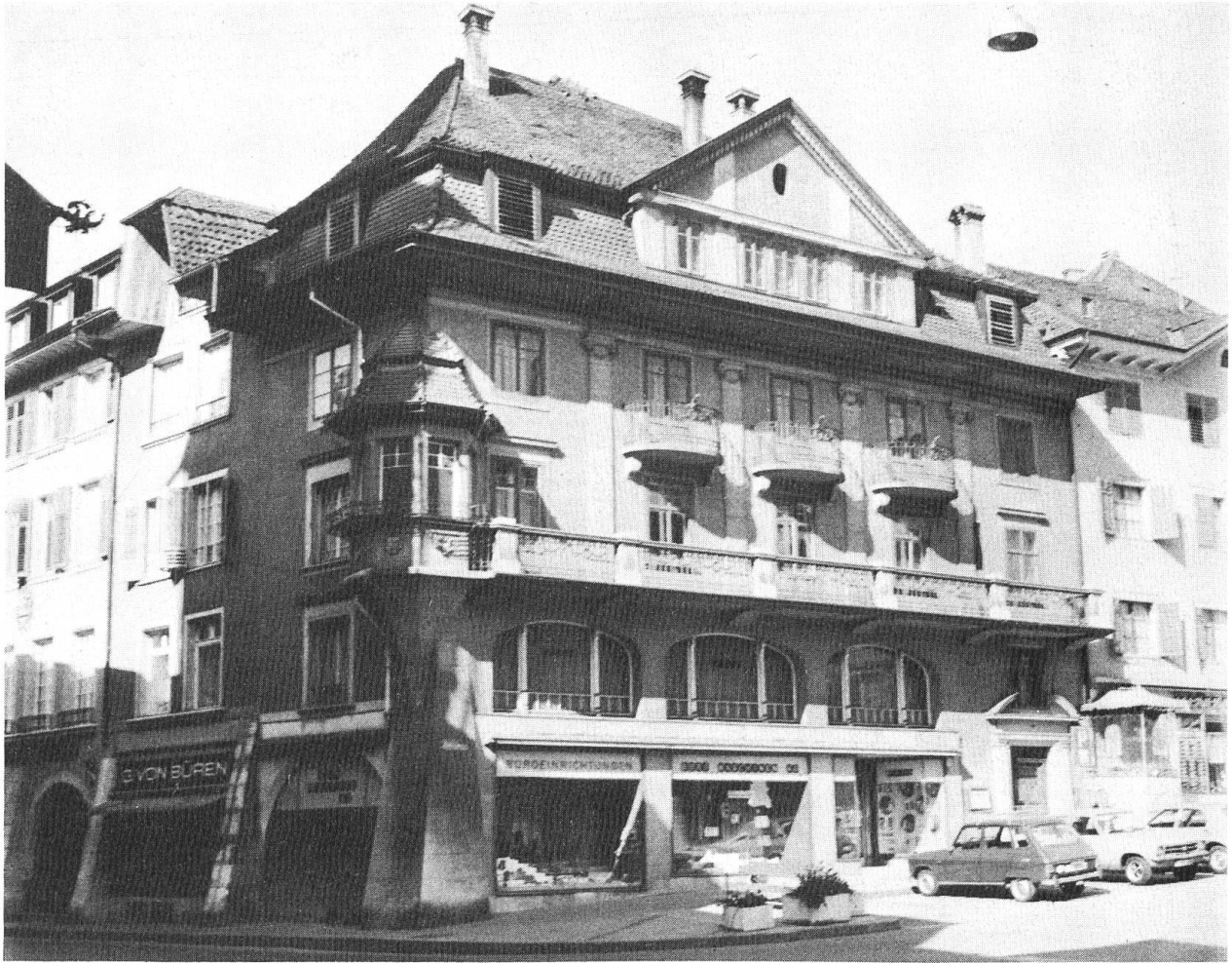
Haus Rust vor Umbau und Renovation.
