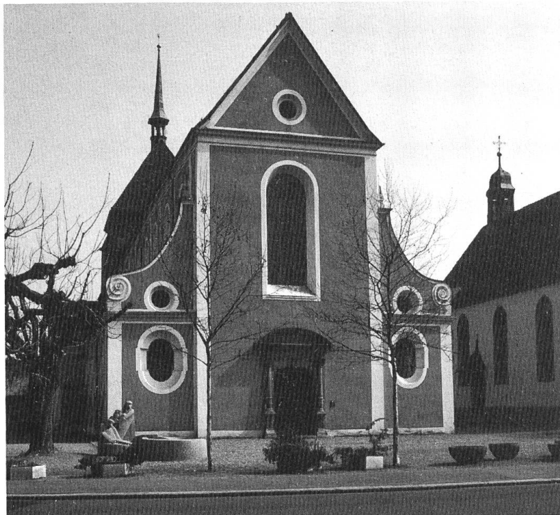
Zurzach, St. Verena, Ansicht von NW.
