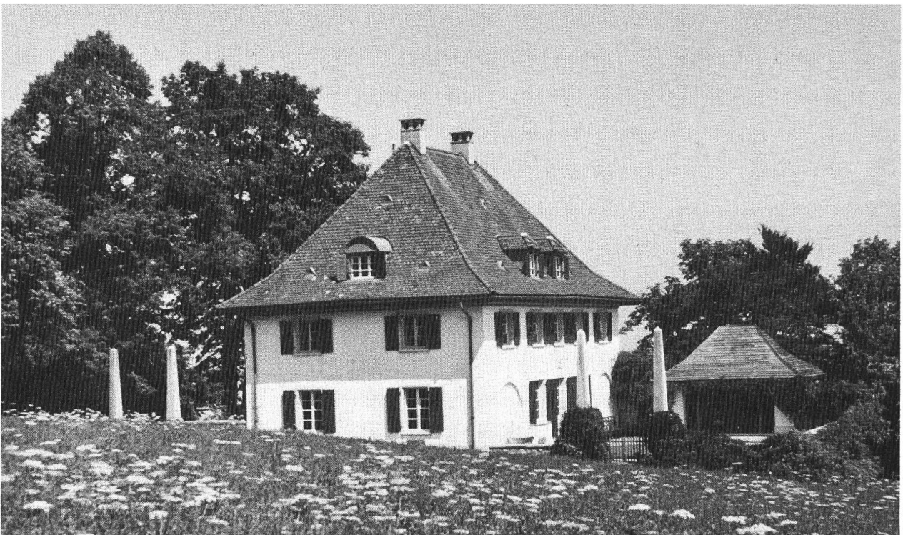
Langenbruck, Landhaus Bilsteinfluh, erbaut 1915 von Hans Bernoulli.
