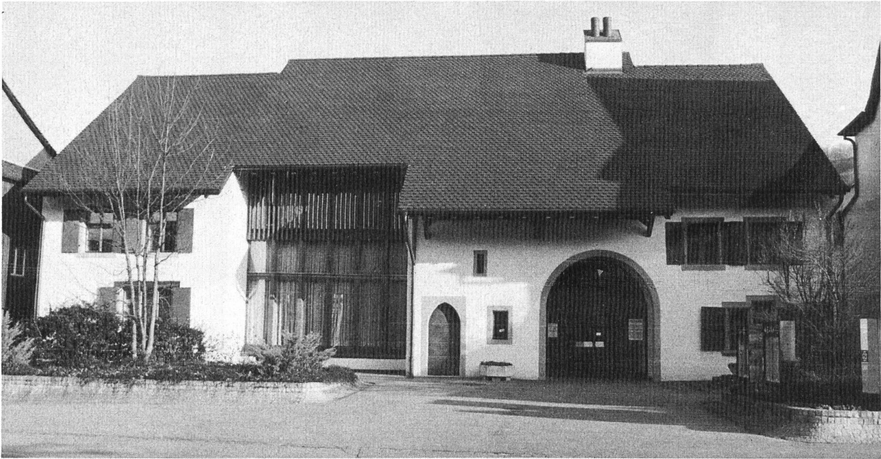
MuttENZ, ehemalige Bauernhäuser Hauptstrasse 16/18, 1974/75 zu einer Bankfiliale umgebaut.
