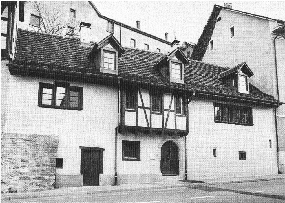
Münchenstein, Haus mit rekon- struiertem Erker, Hauptstrasse 21, erbaut 1651.
