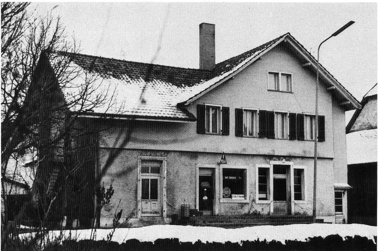
Altes Käsereigebäude in Kestenholz.
