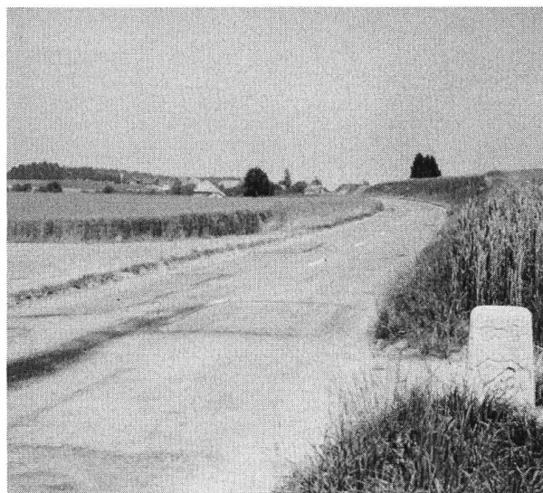
Abb. 8 Ende einer Wandschaft — im Hintergrund Dächer von Gosslwil.
