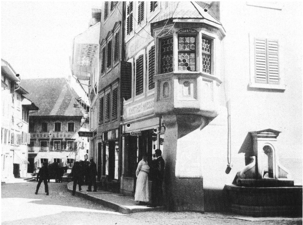
Der «Obere Brunnen» an seinem alten Standort beim Haus mit dem Erker an der Hauptgasse (heute Jelmoli).
