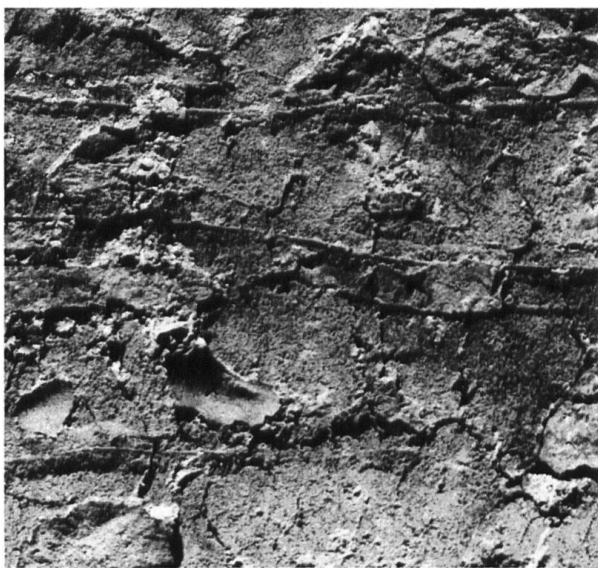
Martinsgasse 13. Rasapietra (mauersichtiger Mörtel) mit Fugenstrich. Die Fugen zwischen den Steinen sind mit der Kelle nachgezogen. 12./13. Jh. — Vgl. dazu Abb. S. 79, bemalte Balkendecke um 1300.
