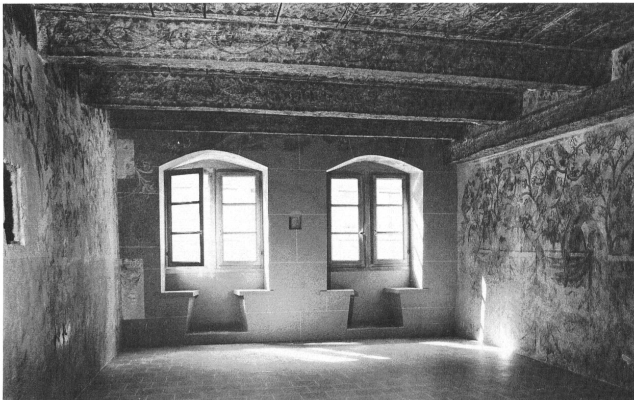
Stadthausgasse 18. Zimmer mit bemalter Balkendecke 14. Jh., Wandmalerei des 15. Jh., Fugenmalerei in den Fenstern 16. Jh.
