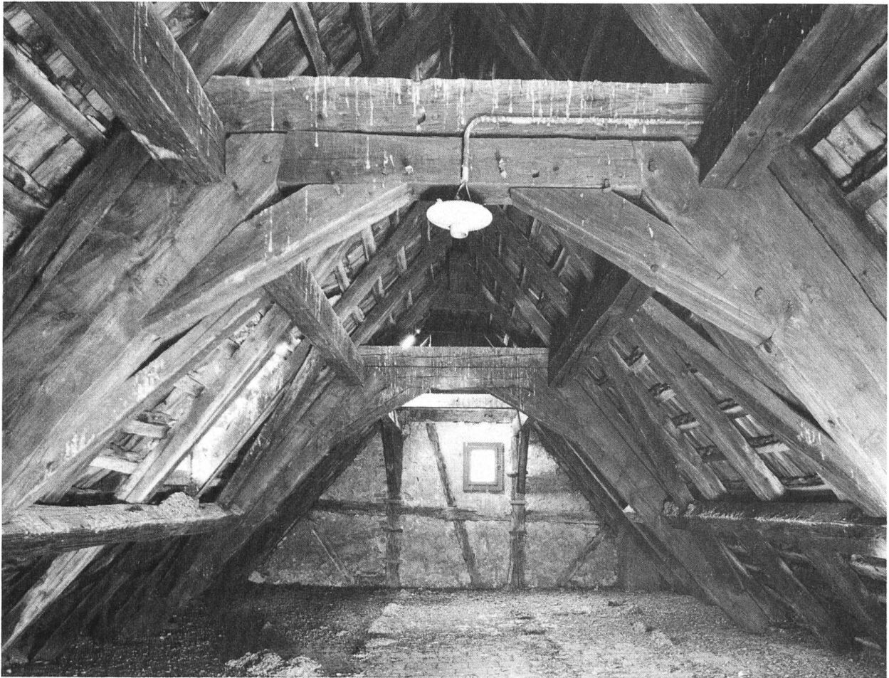
Aeschenvorstadt 50 (abgebrochen). Barocker Dachstuhl.
