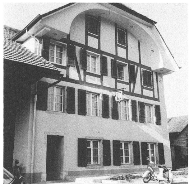
Gasthaus «Sonne», Niederbuchsiten, nach der Restaurierung.
