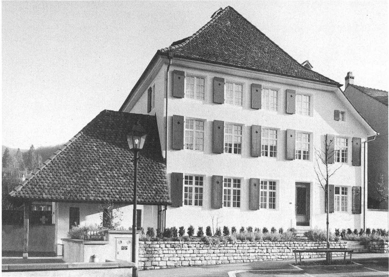
Arlesheim, Ehemaliges Pfarrhaus Eremitagestrasse 25, erbaut 1738.
