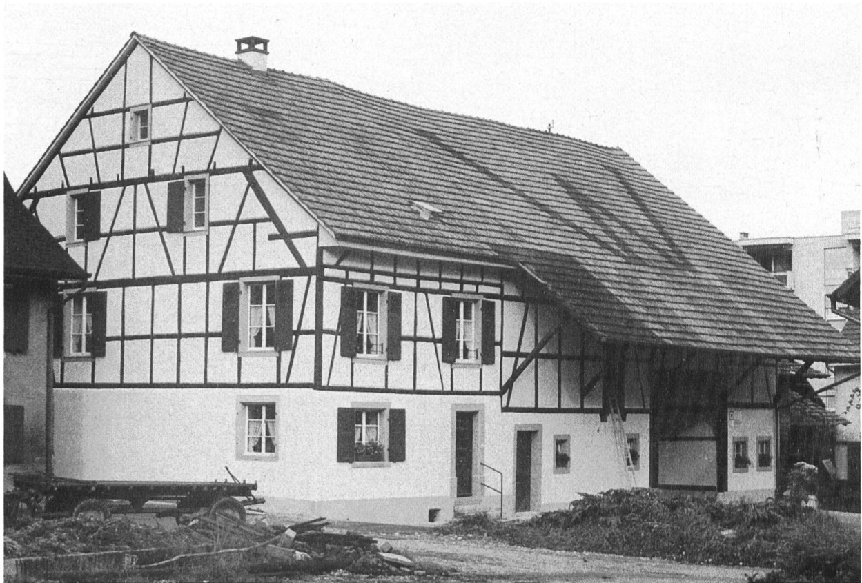
Bottmingen, Fachwerkhaus Bruderholzstrasse 18, erbaut 1746.
