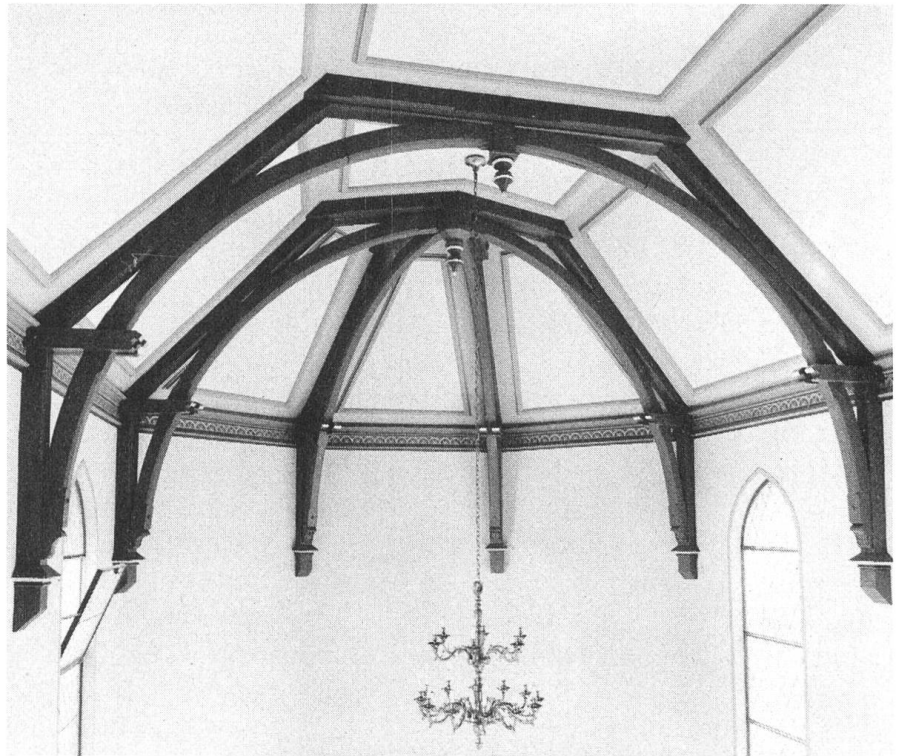
Allschwil, Neugotisches Kirchlein. Inneres mit Blick auf das Gewölbe.
