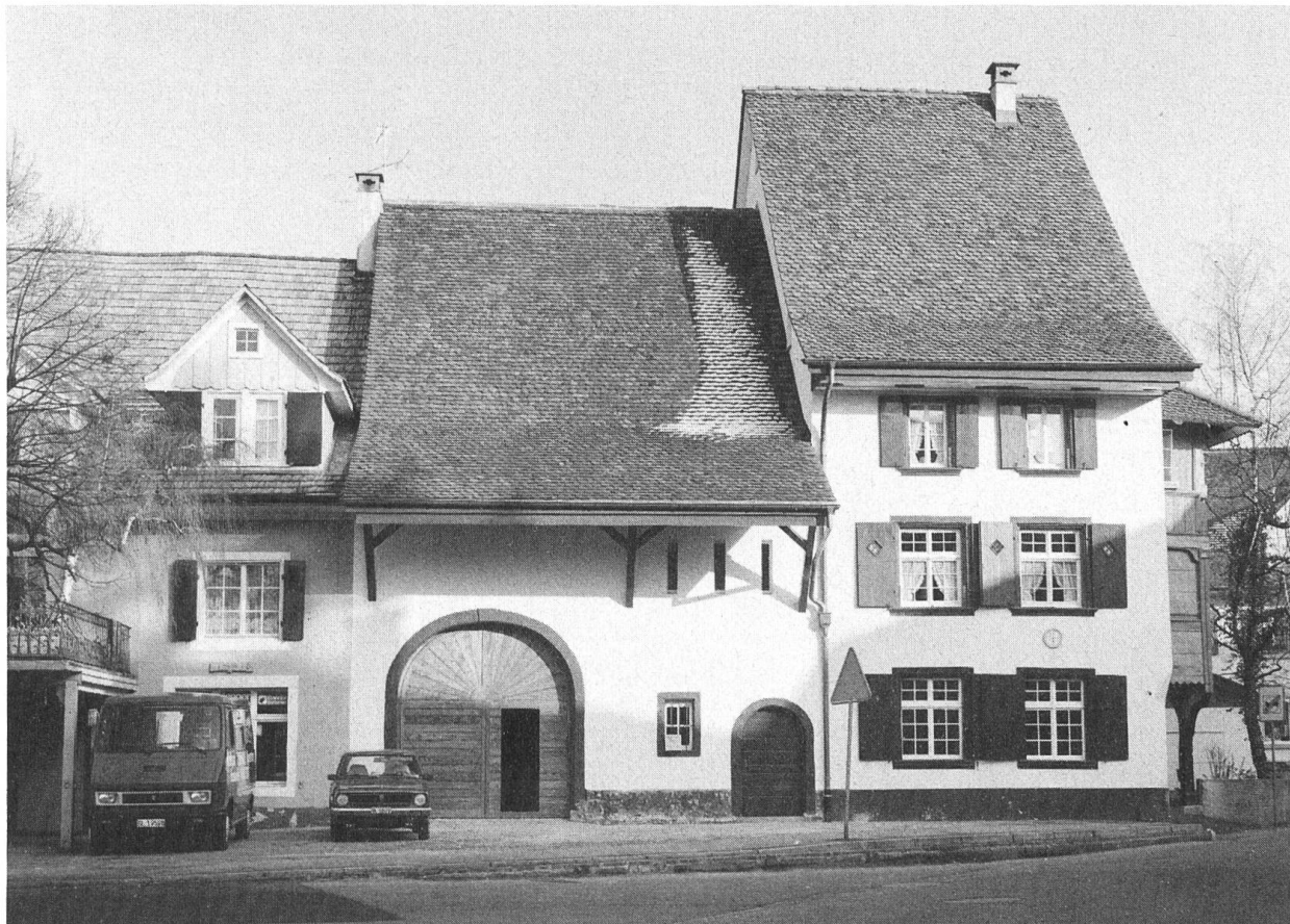
Pratteln, Ehemaliges Lüdin-Haus, Hauptstrasse 33, nach dem Umbau. Äusseres.
