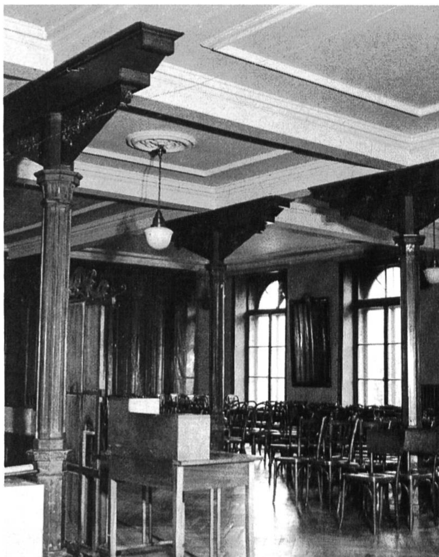
Speisesaal im 1871 erbauten Kurhaus in Langenbruck mit gusseisernen Stützen und Gipsdecken.
