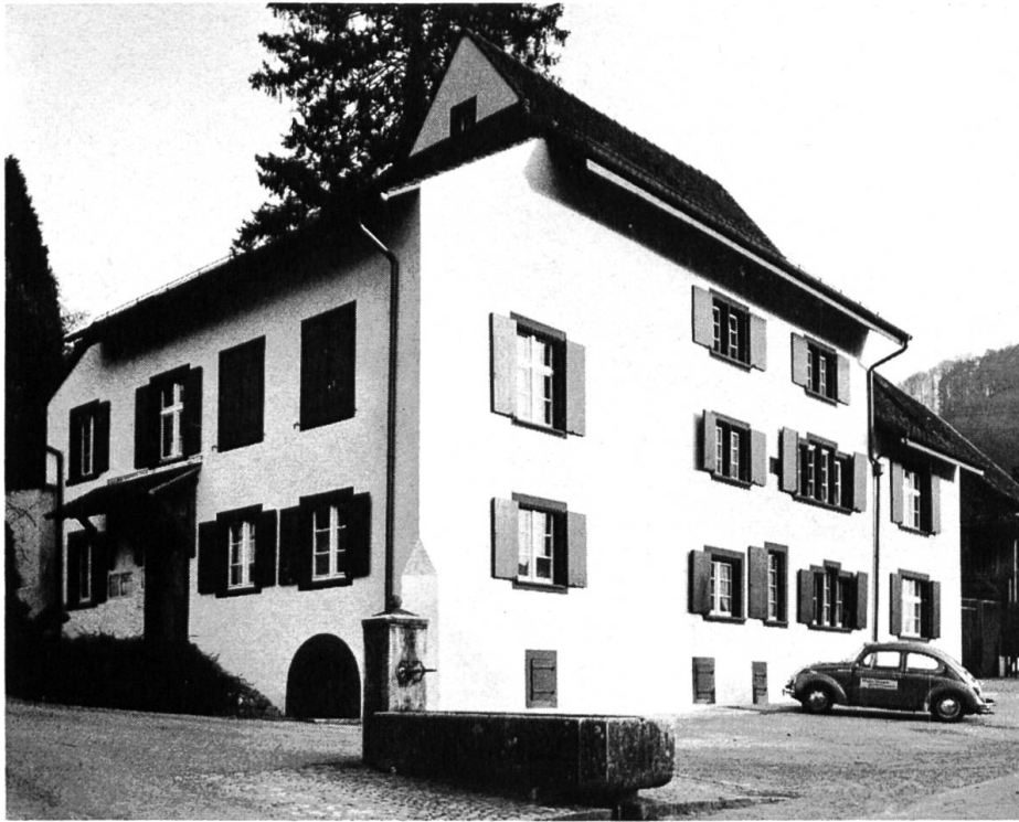
Das Pfarrhaus von Tenniken mit dem dreigeschossigen Kernbau von 1559, dem Pultdachanbau aus dem 17. und dem zweigeschossigen Südteil aus dem 19. Jahrhundert.
