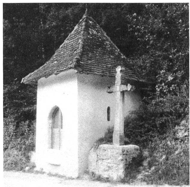
Wegkapelle an der Strasse nach Röschenz.
