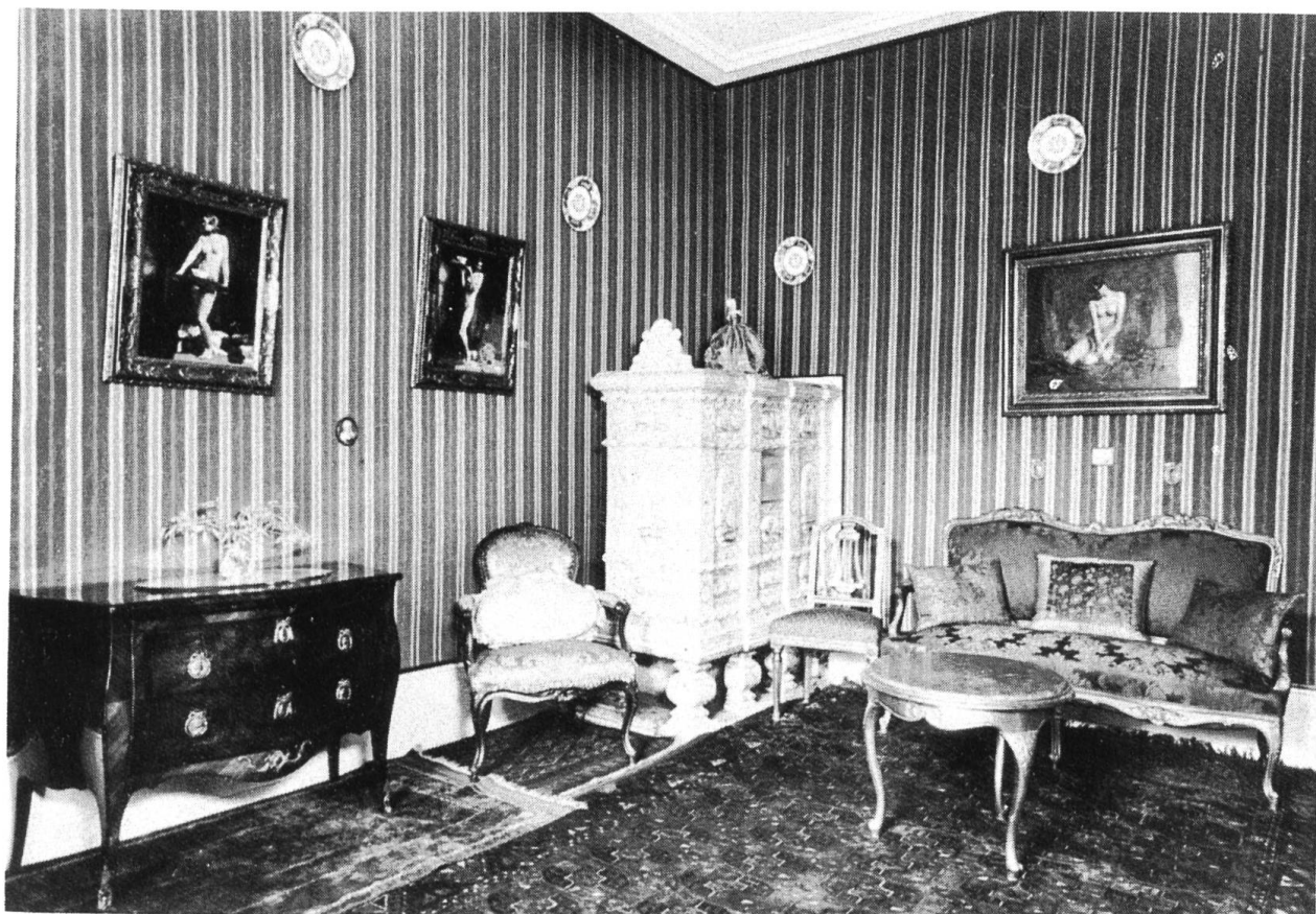
Südwestzimmer im Erdgeschoss.
