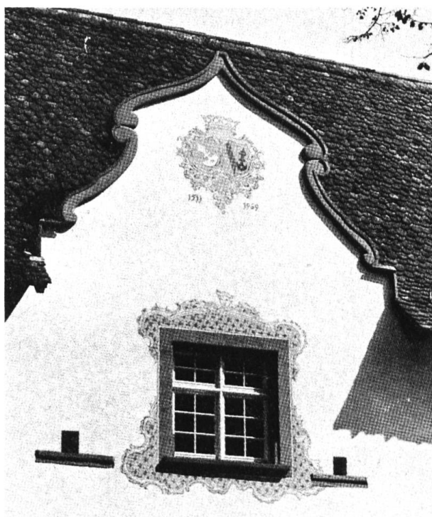
Der barocke Schweifgiebel über dem Eingangstor mit Reichenstein- und Inzlingergemeindewappen. Neben dem Fenster die Führungsschlitze für die Kette der Zugbrücke.
