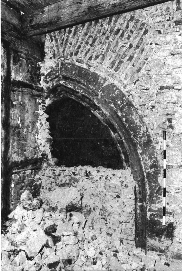
Im Haus Stapfelberg 6 wurden Teile der Eingangsfassade der ehemaligen Augustinerkirche gefunden; Detail des Kirchenportals.
