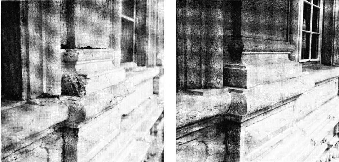
Pfeilerbasis zwischen Fenstern 2. Obergeschoss, vor und nach der Restaurierung (Foto: Architekturbüro Stampfli)
