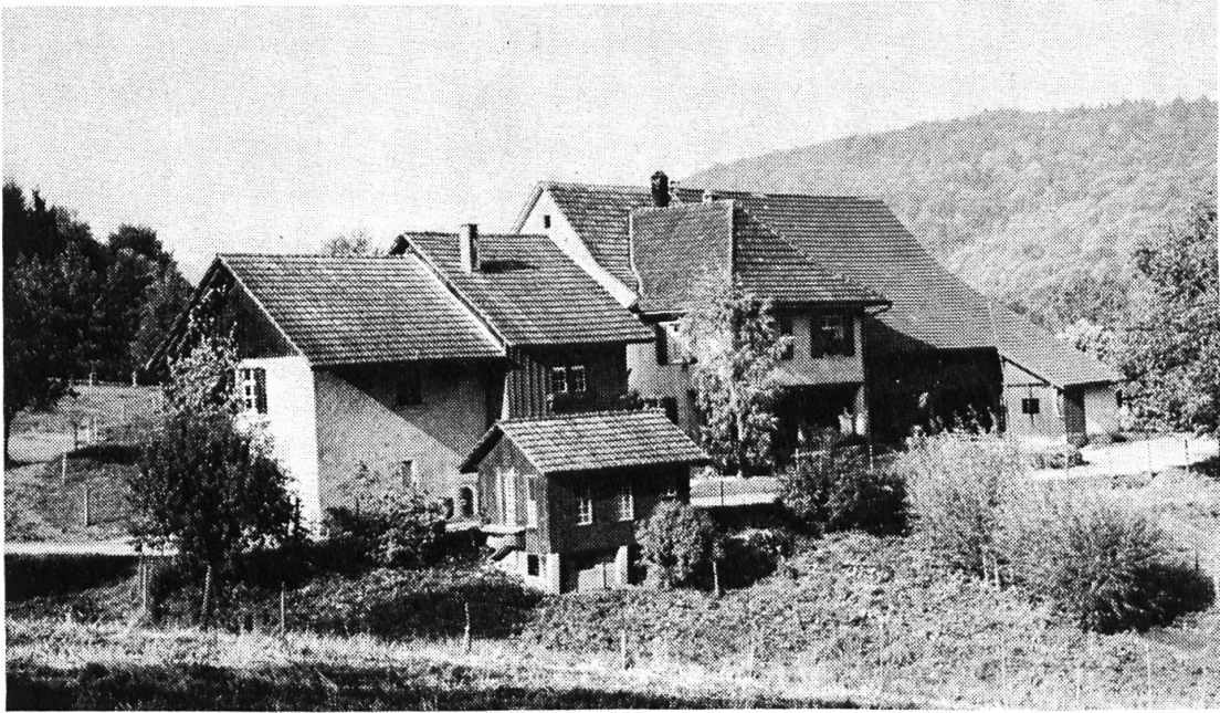
Hof Beckenweid (Hinteransicht)
