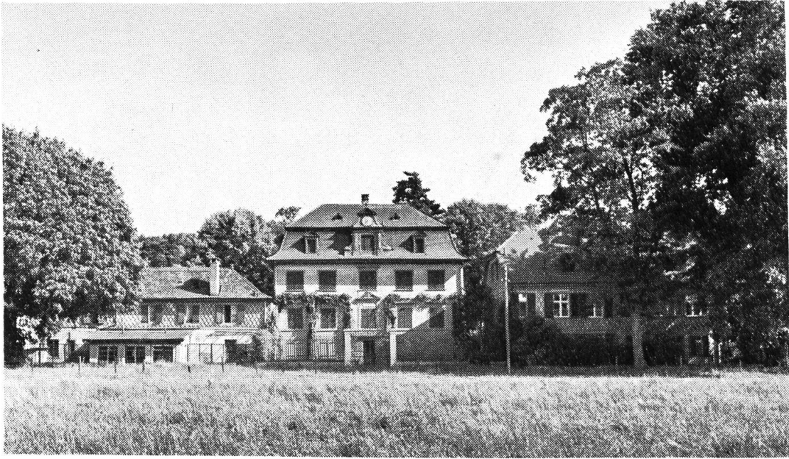
Der Bäumlihof in Riehen bei Basel. In der Mitte das vom Abbruch bedrohte Herrschaftshaus. Kern 1686, 1704 erhöht und erweitert. Dach nachträglich verändert. (Photo H. R. Clerc, Basel)
