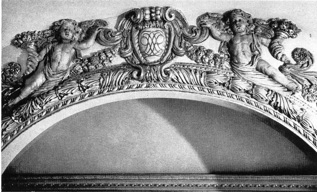
Stukkaturen aus dem Theatersaal
