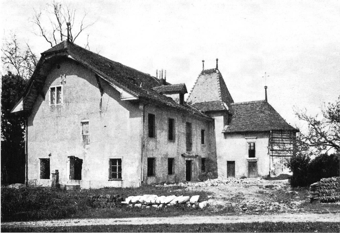
Das Schlösschen zu Beginn der Wiederherstellungsarbeiten
