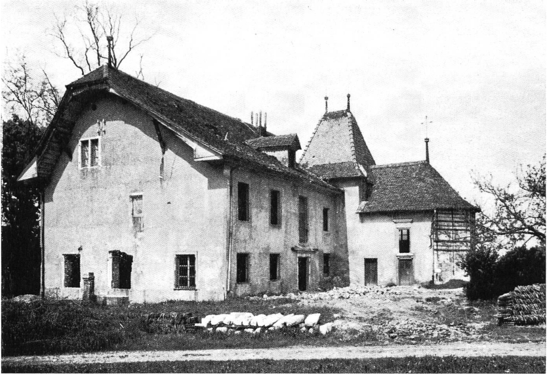
Das Schlösschen zu Beginn der Wiederherstellungsarbeiten
