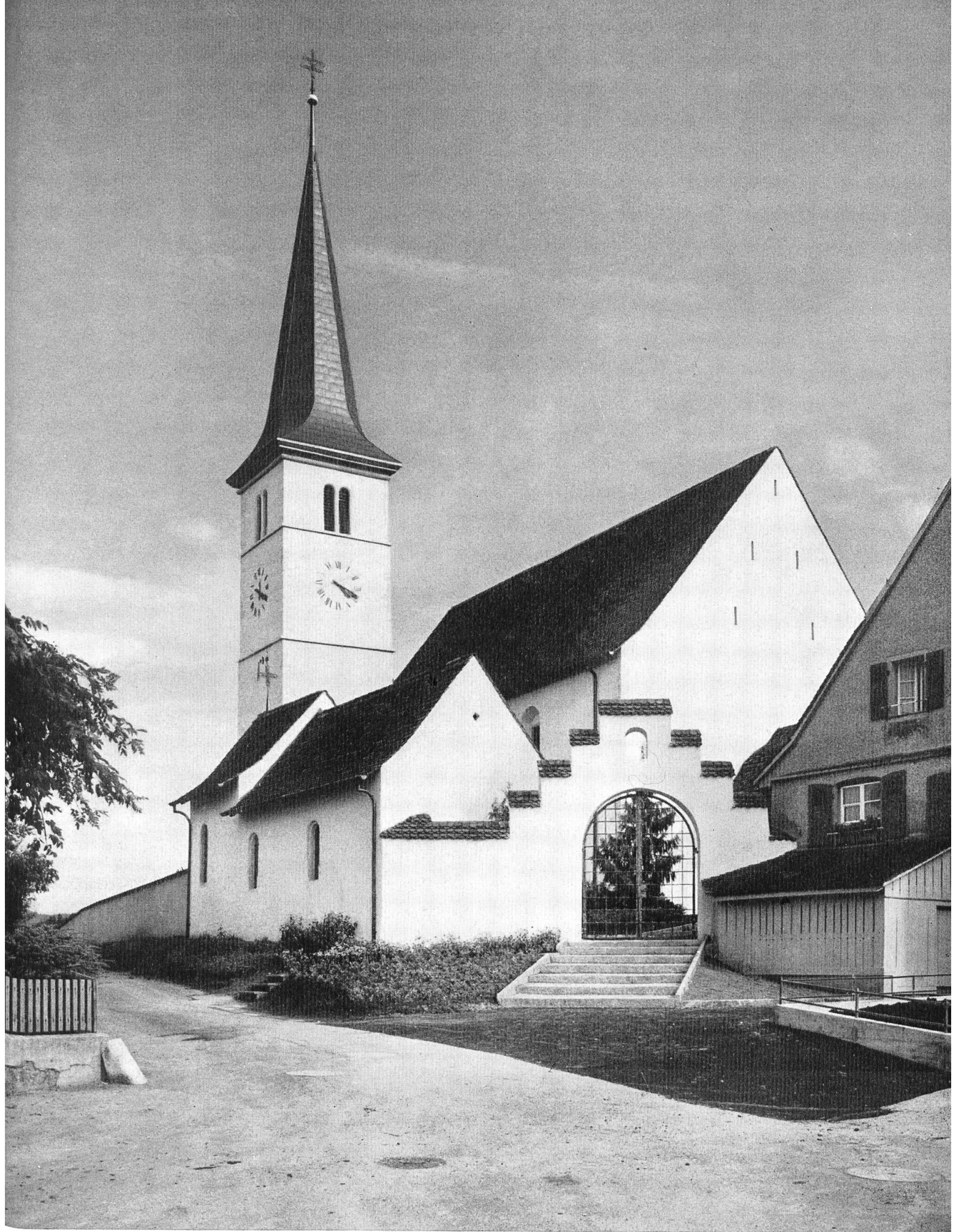
St.-Stephans-Kirche, Gesamtanlage. 1627—1631 erbaut
