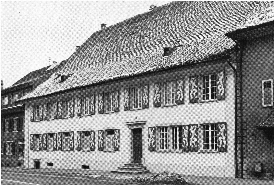
Balsthal. Südfassade des «Löwen» nach den Erneuerungsarbeiten. Photo Kunstdenkmäler Solothurn, Aufnahme Räss.
