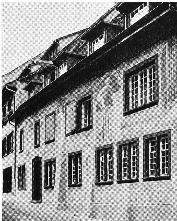
Gemsberg 4. Nebengebäude des Restaurants Löwenzorn. Fassadenmalerei, Scheinarchitektur, um oder nach 1600. (Aufnahme H. Jaeger, Basel).
