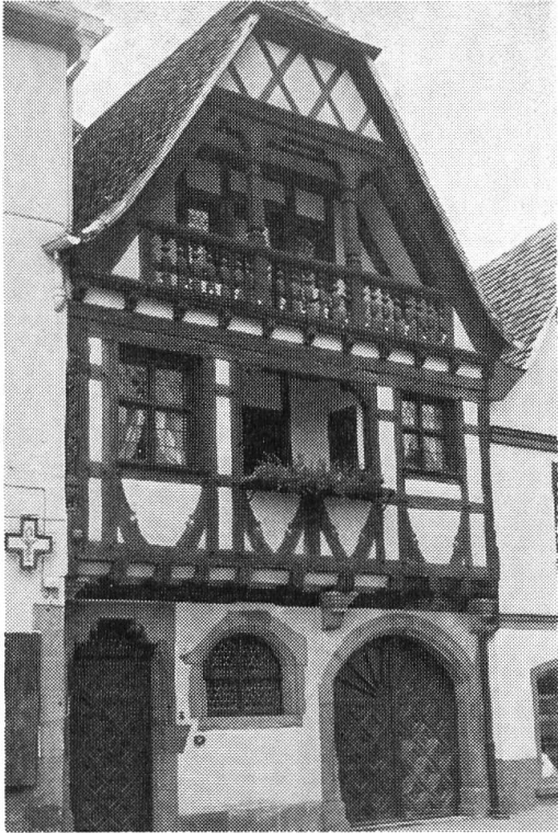
Obernai. Vorbildliche Restaurierung
