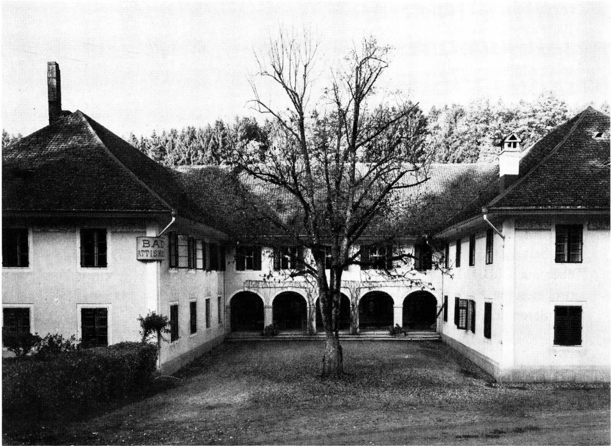
Bad Attisholz um 1925 (Denkmalpflege).
