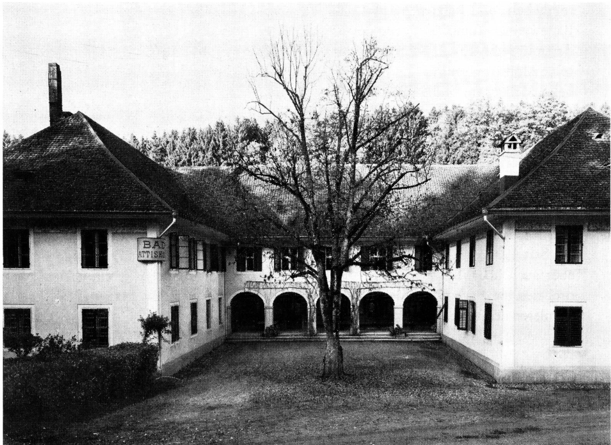
Bad Attisholz um 1925 (Denkmalpflege).
