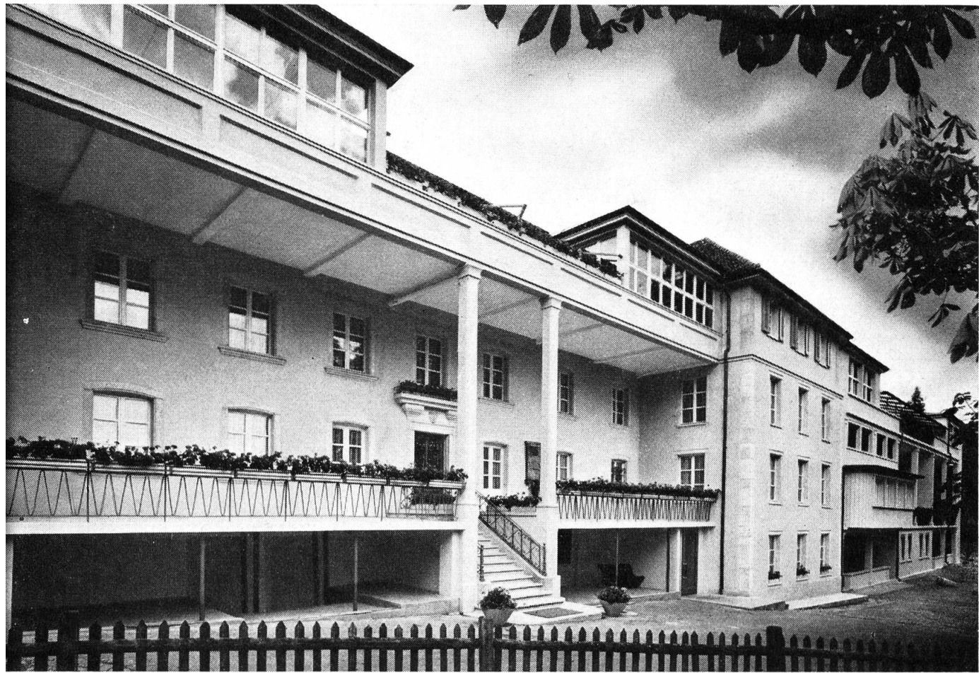
Hauptgebäude des Kinder- und Erziehungsheims St. Josef in Grenchen
