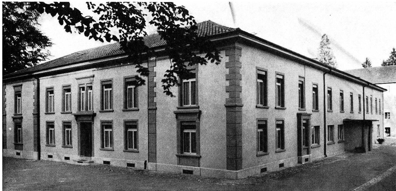
Knaben- und Schulgebäude
