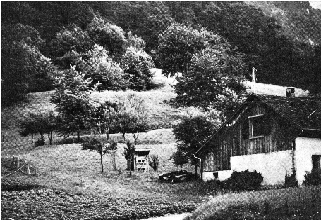
Terrassierte Abraumhalde beim Hof Schad. Hinter dem Gebüsch oben links befindet sich die Stützmauer des Stollen- oder Schachteingangs. Das Haus gehörte einst zur Erzwäsche.
