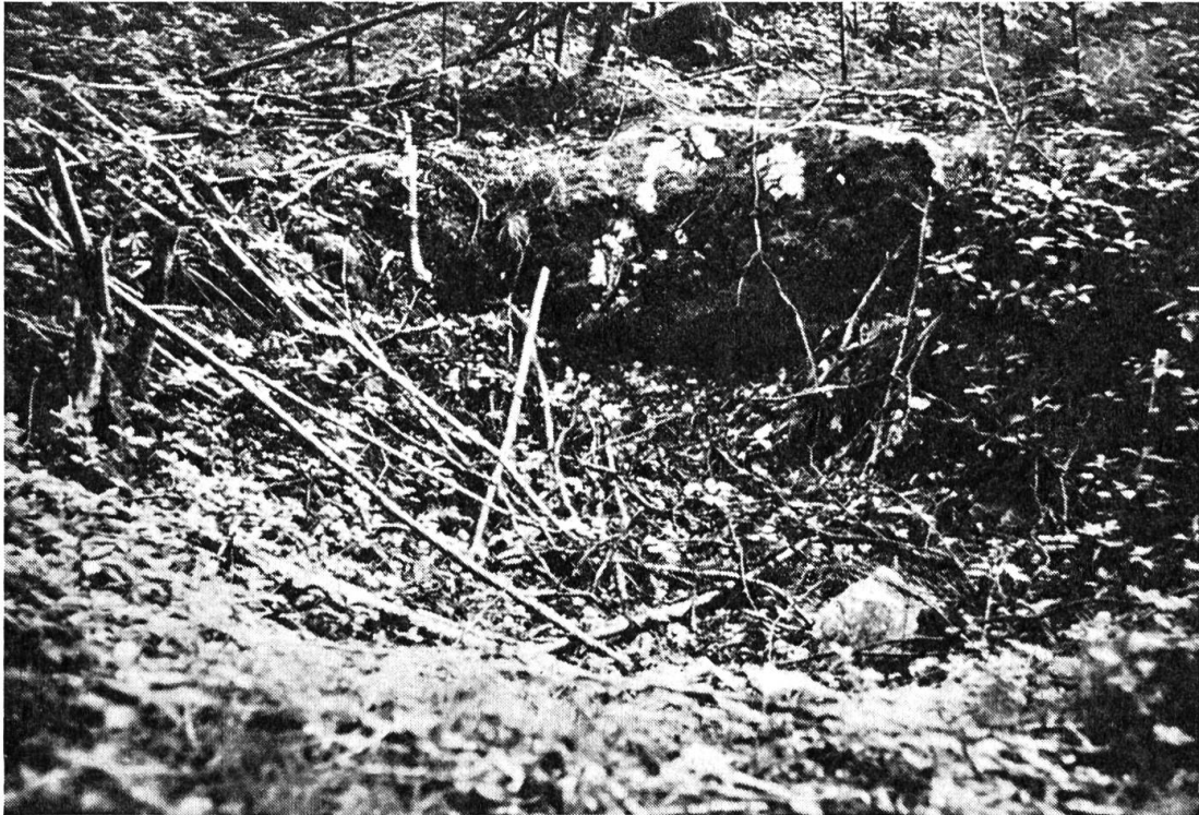
Eingestürzter Schacht im Wald über dem Hof Faichlen.
