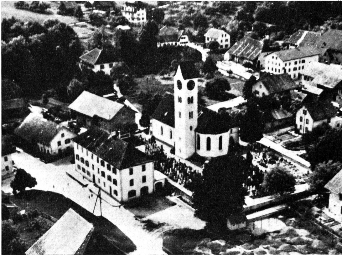
Dorfkern von Selzach mit Kirche und Schulhaus, Blickrichtung NW. Östlich des Chores wäre die neue Kirche mit Flachdach vorgesehen. (Flugaufnahme Photo Amiet, Grenchen).
