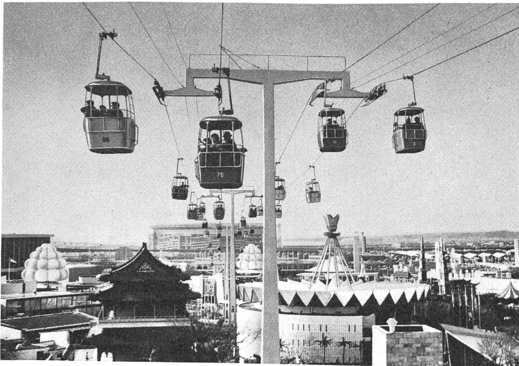
Werk Bern: Einseil-Umlaufbahn (Sesselbahn) an der New Yorker Weltausstellung 1964/65, gebaut als Doppelanlage mit einer stündlichen Förderleistung von 2200 Personen in jeder Richtung
