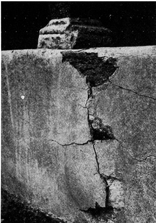
Zwei Krebsübel an unsern Baudenkmalern: der Zementmantel , unter dem die alten Bruchsteinmauern ersticken und der Stockhammer , der die schönen Werkstücke aus Naturstein zugrunde richtet.
