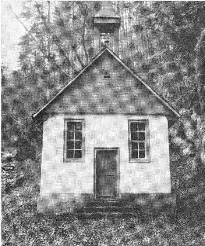
Die Horngrabenkapelle ob Matzendorf glich vor der Restaurierung eher einem verlassenen Waschlhäuschen.
