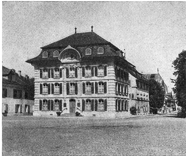
Das «Neuhaus» am Thutplatz in Zofingen, erbaut 1770, renoviert 1956/57
