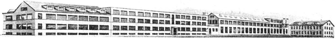
Gesamtansicht der Brac AG. Breitenbach.
