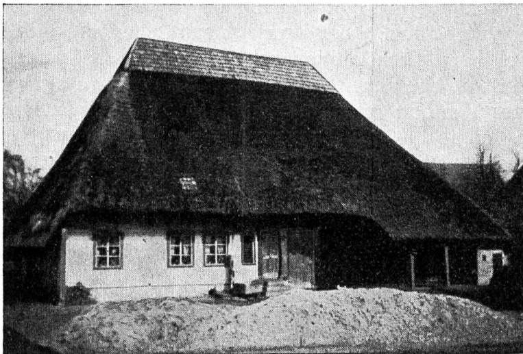
Das letzte Strohhaus von Fulenbach.
