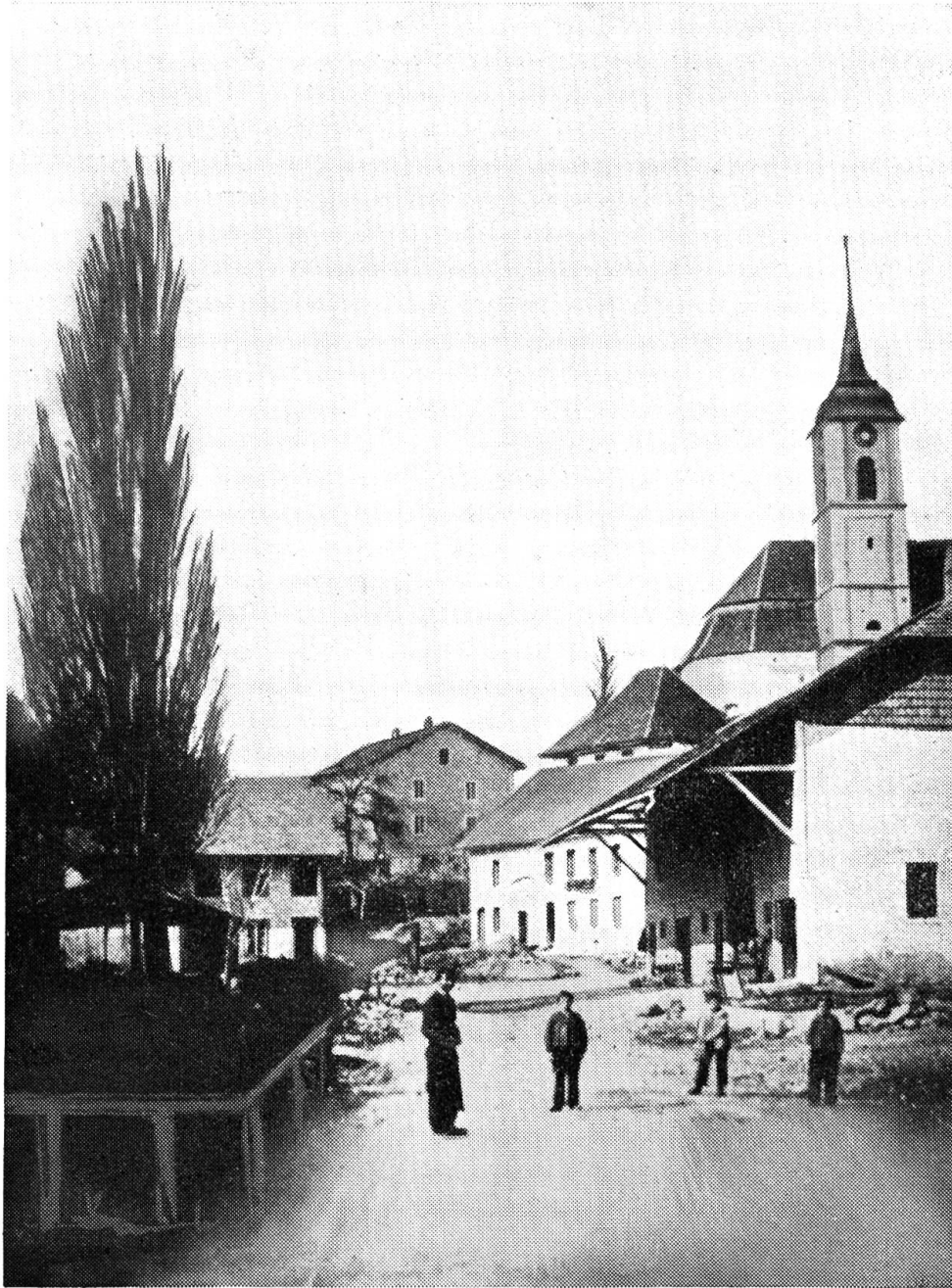
Partie aus dem alten Grenchen.
