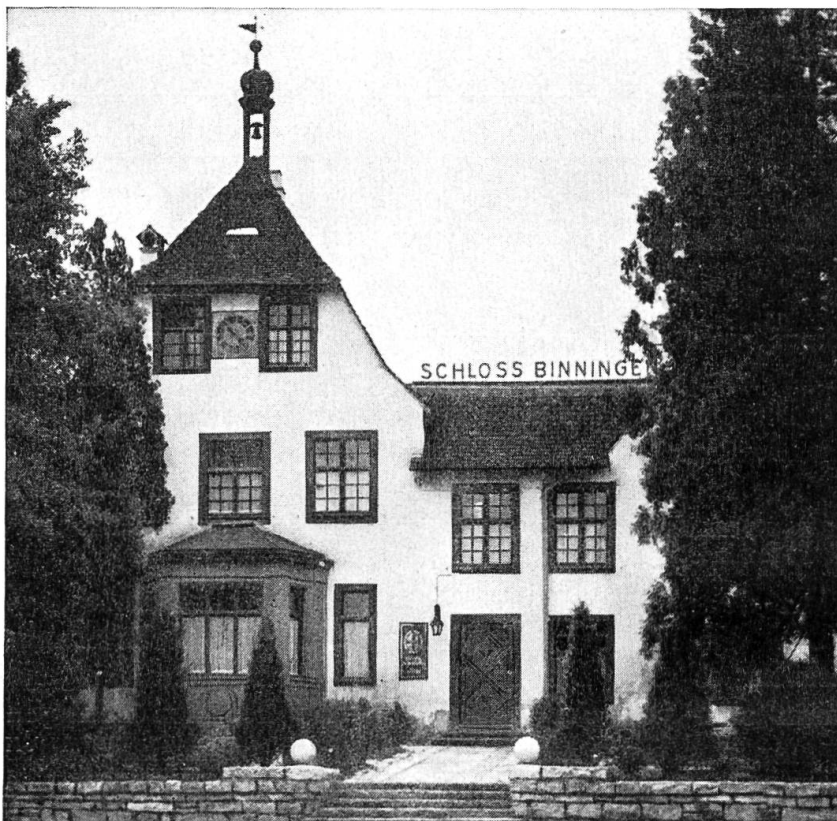
Schloss Binningen Eingangspartie
