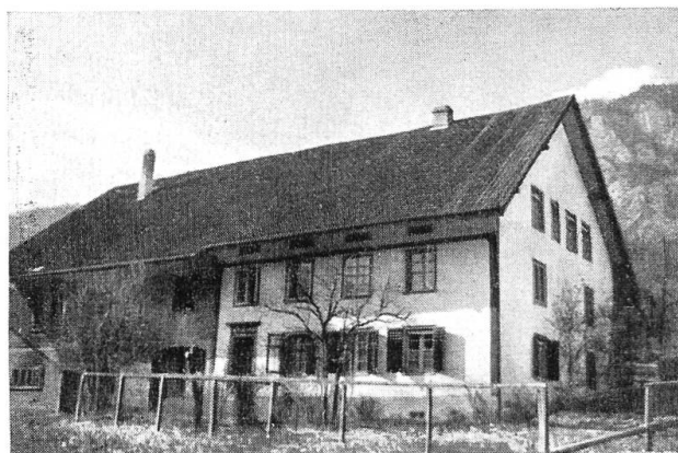
Foto: K. Fussinger. s'Tschärge Hus in Welschenrohr, wo die ersten Uhren gemacht wurden.
