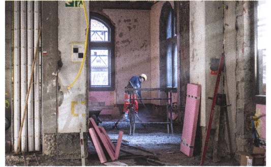
Kurz nach der Eröffnung des Erweiterungsbaus gingen die Sanierungsarbeiten mit dem Ausbau der historischen Zimmer im Westflügel weiter.
