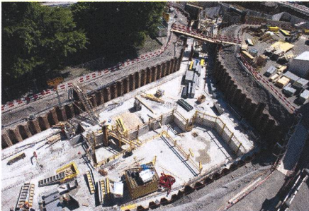
Bau des Fundaments für den Erweiterungsbau.
