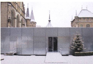
Während der Bauzeit fanden Wechselausstellungen im Pavillon im Innenhof statt.
