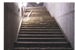
Das grosse Treppenhaus im Herzen des Erweiterungsbaus entsteht.
