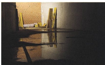
Mit der Fertigstellung des Rohbaus im November 2014 konnte der Einbau von Heizung, Lüftung etc. beginnen.
