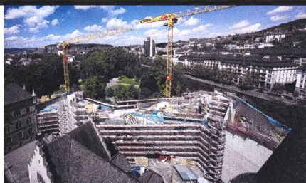
Fortschreitende Arbeiten am Erweiterungsbau.
