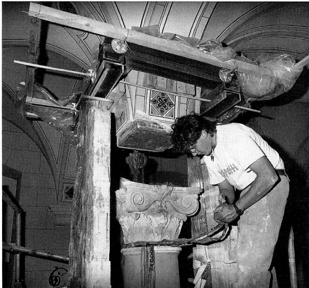
Abb. 4 Ausbau eines Kapitells in der Eingangshalle des Museums.
