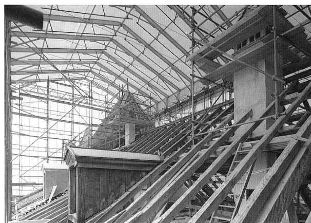
Fig. 11. La charpente découverte protégée par le toit provisoire. Photo Henri Germond, Lausanne.
