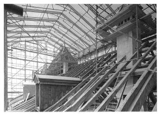
Fig. 11. La charpente découverte protégée par le toit provisoire. Photo Henri Germond, Lausanne.
