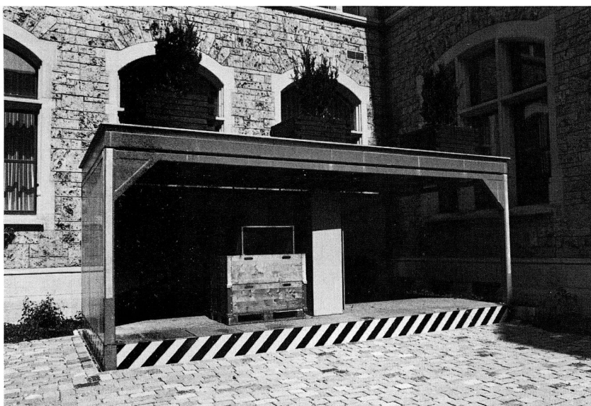
Abb. 100. Im Hof des Landesmuseums neuin- gebauter Transportlift für schwere Lasten. (S. 82)
