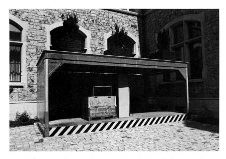
Abb. 100. Im Hof des Landesmuseums neueingebauter Transportlift für schwere Lasten. (S. 82)
