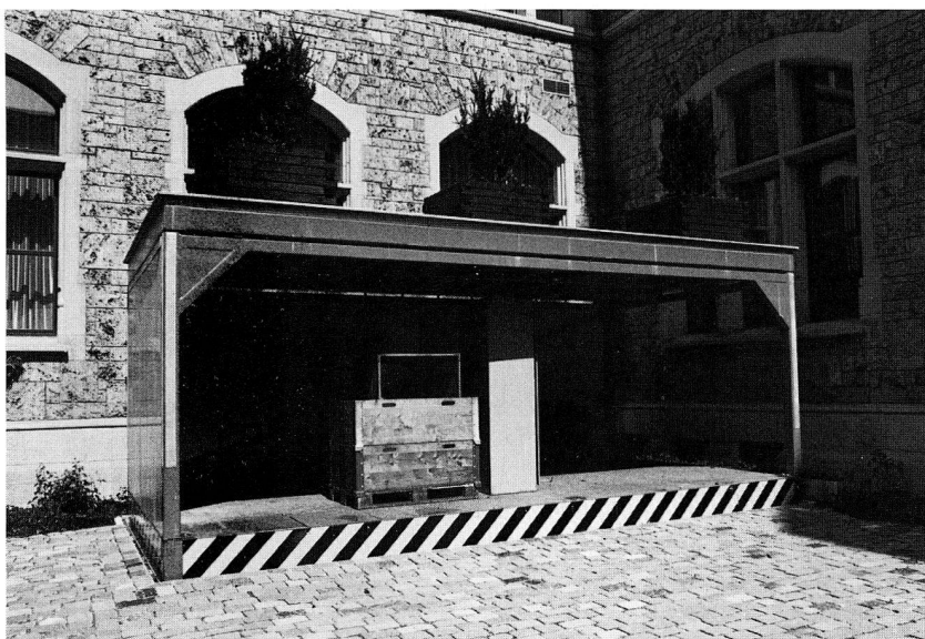
Abb. 100. Im Hof des Landesmuseums neu- gebauter Transportlift für schwere Lasten. (S. 82)
